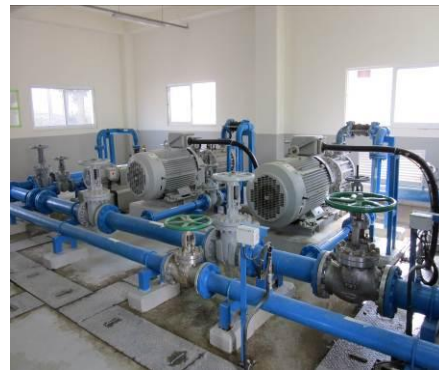
アダシアポンプ場
