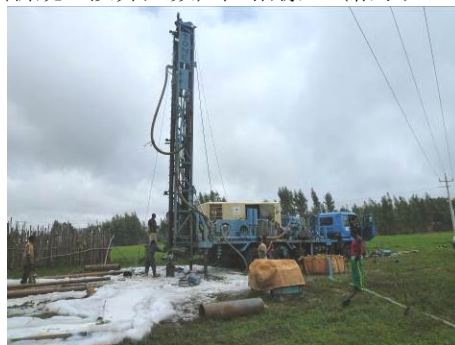
井戸掘削リグ
