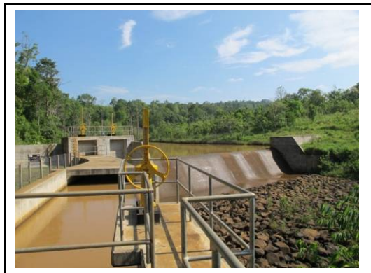
オモレン水力地点 取水堰および沈砂池
