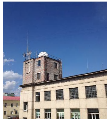
黄砂モニタリングデータ受信設備
