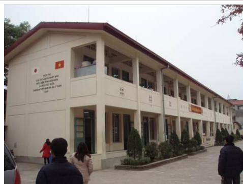
本事業で整備された校舎
