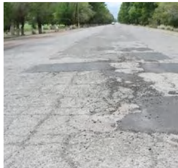
修繕後の BNT 道路 （2012 年 6 月 8 日）
