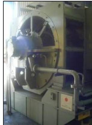
新設されたディーゼル発電機
