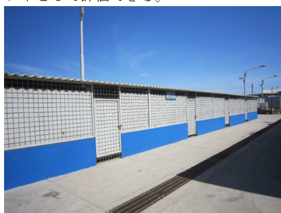
写真：自助努力で建設された更衣室
