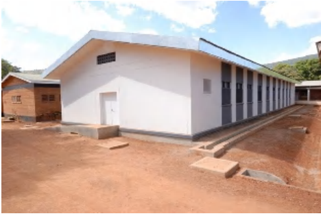
ルンピ県病院産科棟
