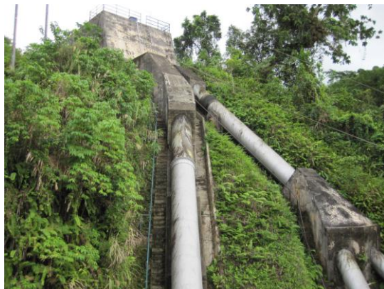
写真 2：敷設された導水管（左側）
