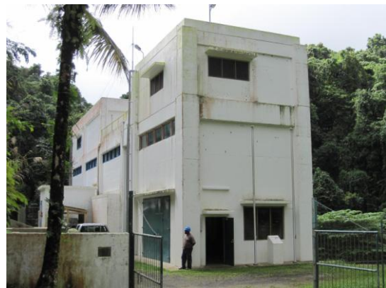
写真 3：水力発電所建屋全景
