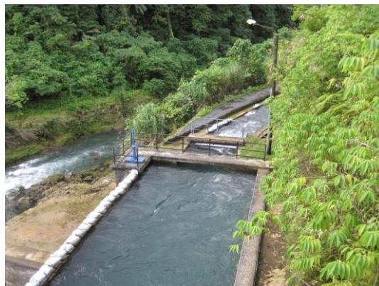
写真1 導水路の現況
