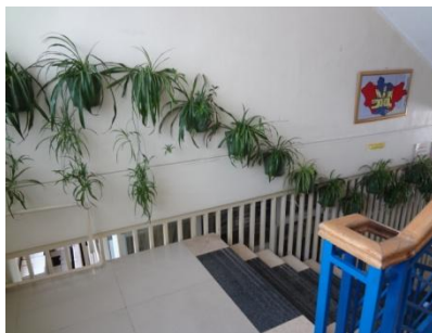
(丈夫な素材に貼り替えられた廊下・階段)
