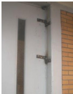
（修理されたドア）
