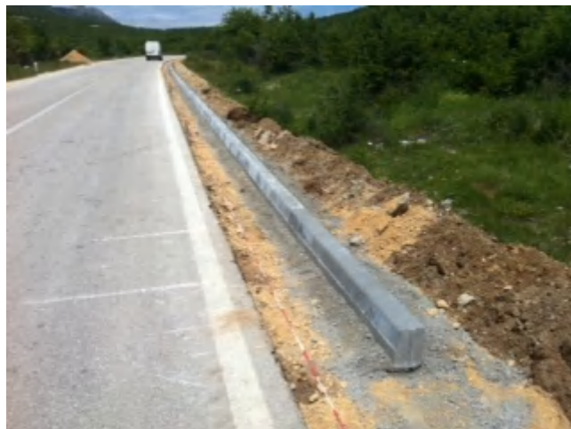
路肩補強工事の現場
