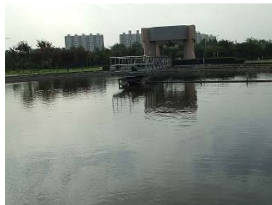
第 3 下水処理場
