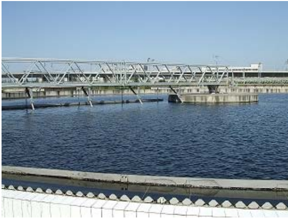
第 4 下水処理場
