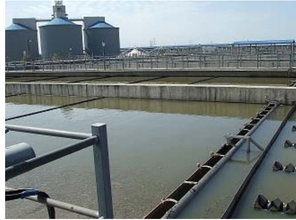
第 4 下水処理場
