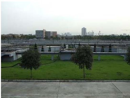
第 3 下水処理場
