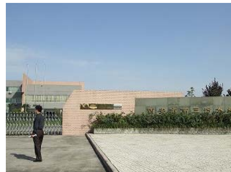
西安市第3下水処理場
