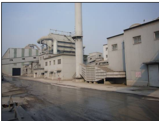
スラグ処理設備
