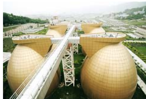
鶏冠石下水処理場消化池
