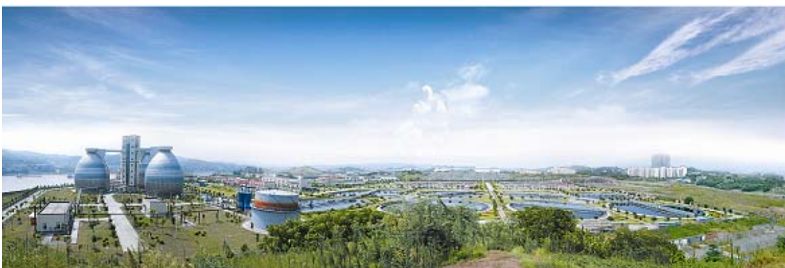
唐家沱污水处理場（左奥が長江、左の卵型設備が消化池、右が沈殿池、生物反応池等） 写真提供：重慶排水公司
