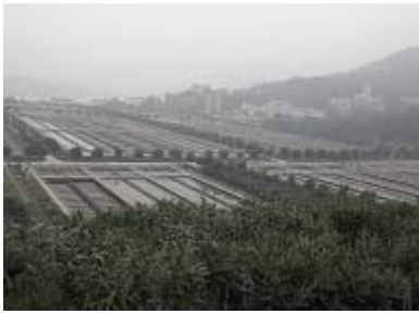
沈殿池と生物反応池全景
