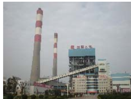
韓城第2火力発電所
