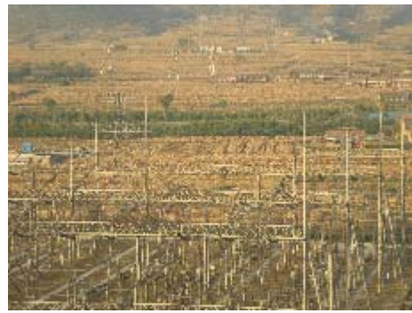
発電所から山東省へつながる送電線
