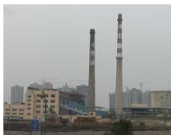
塩島熱電工場全景
