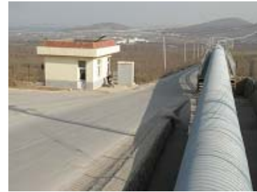
石灰石用ベルトコンベヤー
