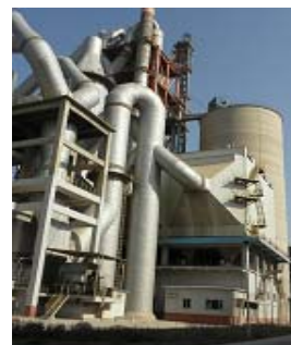
キルン出口の電気集塵機（右四角部分）
