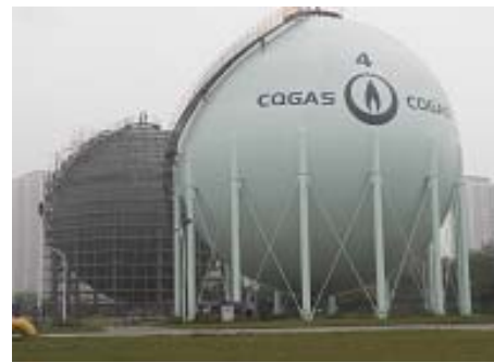
頭塘天然ガスステーション
