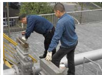
同ステーションの点検中職員
