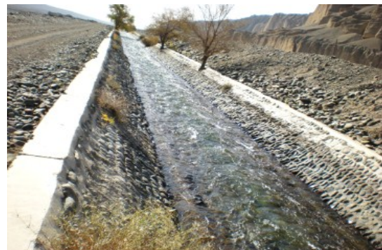
幹線水路（トルファン）
