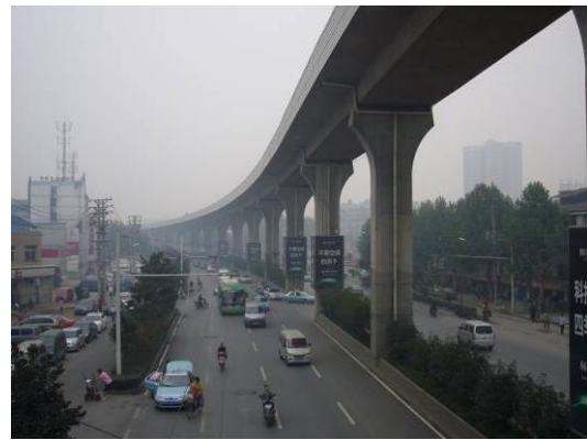
高架部軌道（京漢大道）
