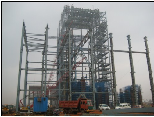
建設工事中の NHPC バイザック火力発電所 (2011 年 12 月撮影)
