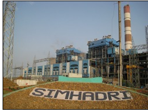
NTPC シマドリ火力発電所
