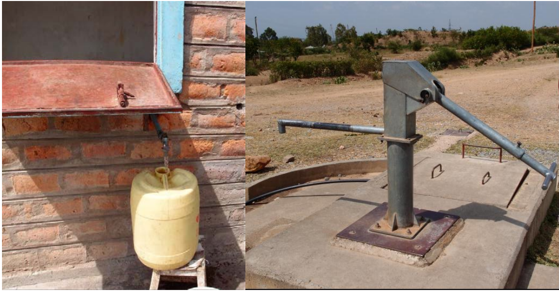
減水区間の給水施設（水道）
