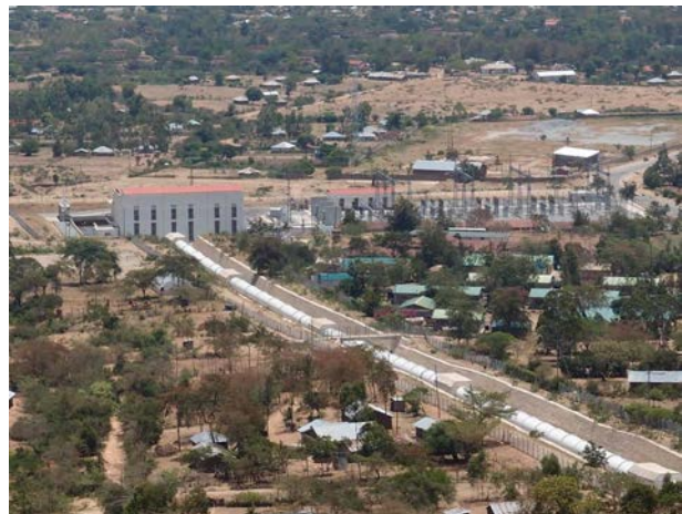
ソンドゥ・ミリウ水力発電所
