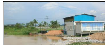
写真2：ペナン州水道公社 のムダ川からの 取水ポンプハウス
