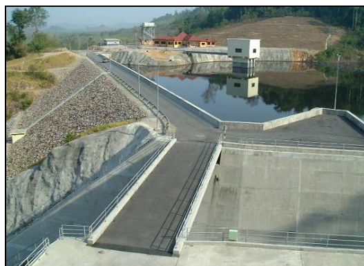
ベリスダム(メインダム)
