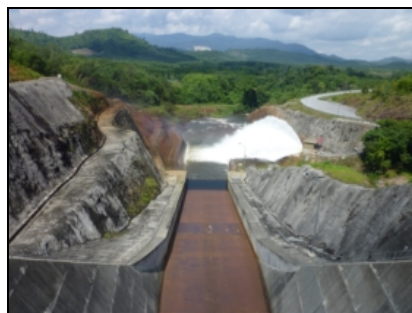
写真 1：余水吐と放水路
