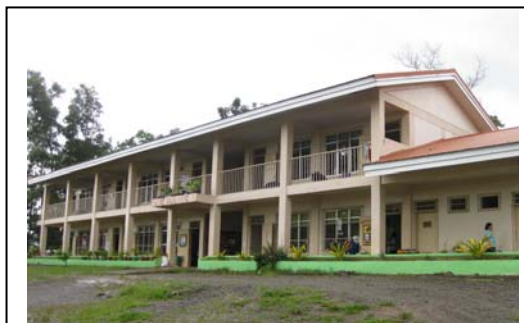
本事業により建設された校舎
