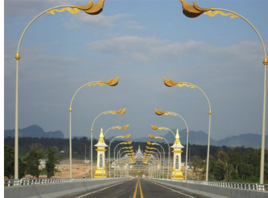
図 4：第 3 メコン国際橋
