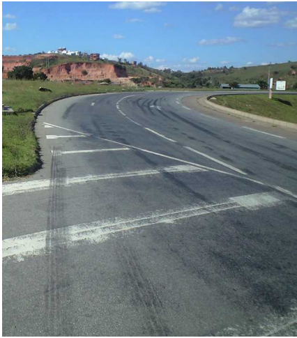
10k000 付近、アラスラ(Alasora) コミューン内
