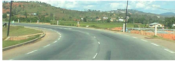
9k600 付近、アラスラ(Alasora) コミューン内
