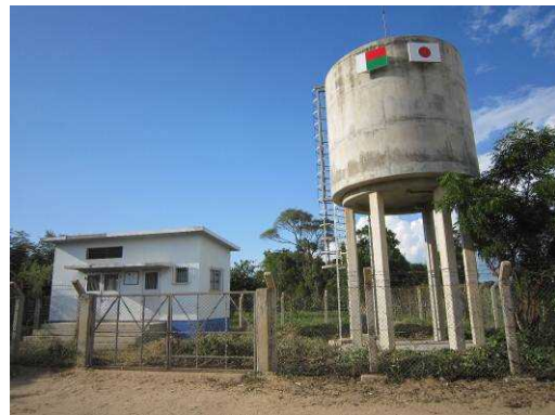
本事業の公共水栓型給水施設
