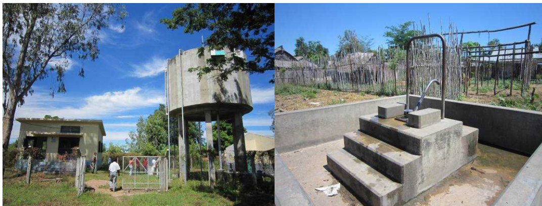
写真 1：公共水栓型給水施設
