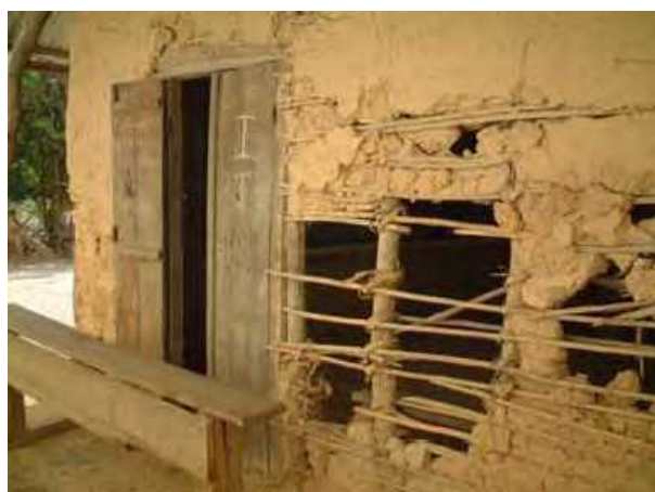
コミュニティによる土壁の教室
