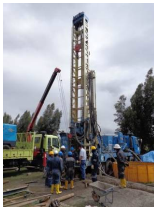
本事業にて調達された掘削機
