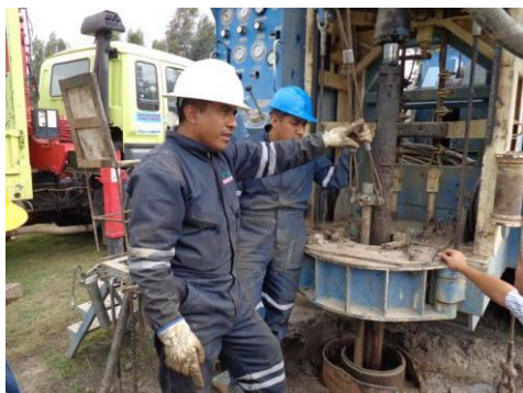
井戸掘削現場で指示を出す技術者
