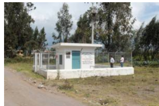
本事業にて建設された井戸建屋
