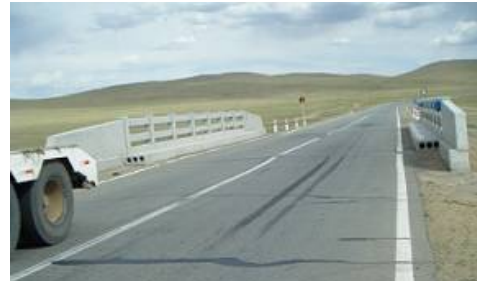
（写真）建設されたフッサーナリン橋
