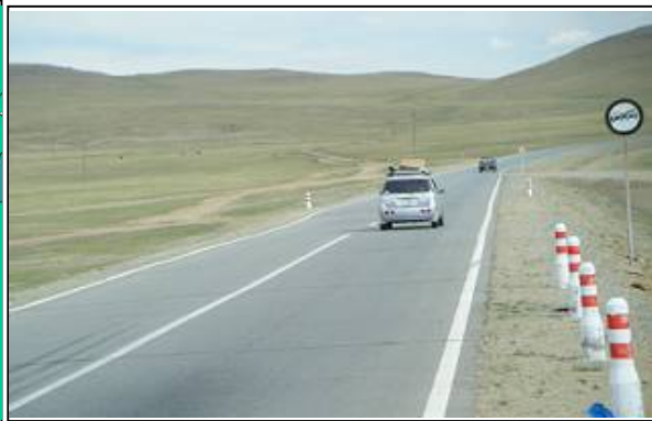
本事業で整備した道路
