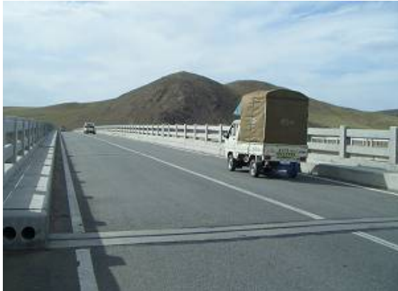
(写真) 区間 II に建設されたヘルレン橋
