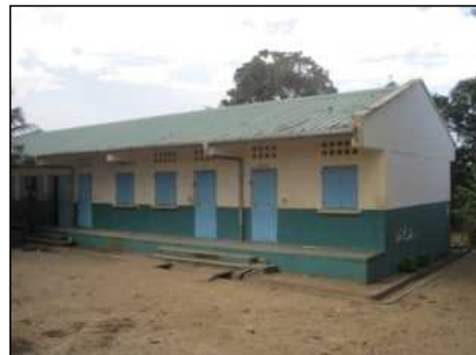
本事業により建設された校舎 (アンツィラナナ州)
