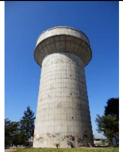
イカ郡マンサニーヤ地区に新設された給水塔
