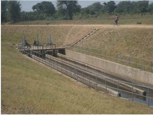
写真 3：新設された沈砂池
