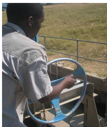
写真 6：沈砂池ゲート操作中の水管理人
