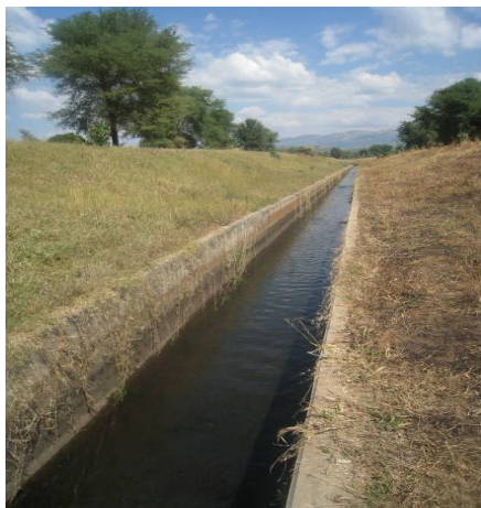
写真 1：移設された新規幹線水路
