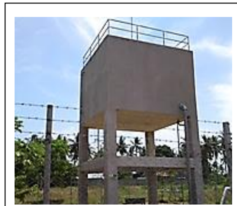
本事業によって建設されたレベル 2 施設
