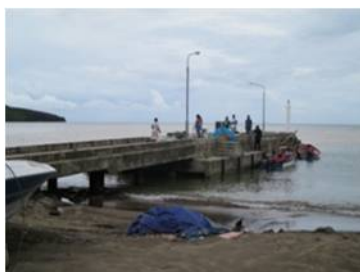
栈橋：出漁準備・水揚げ作業が効率化された
