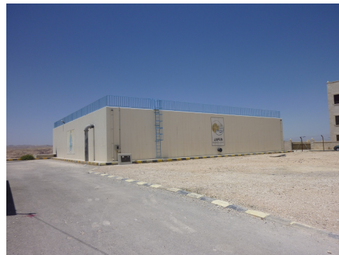
写真 2：ザルカ市北部配水池
