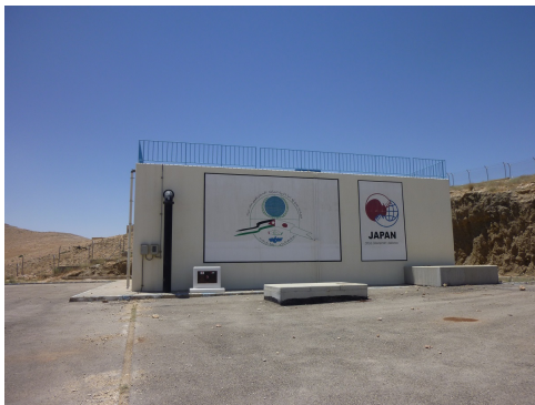
写真 1：スフナ配水池
