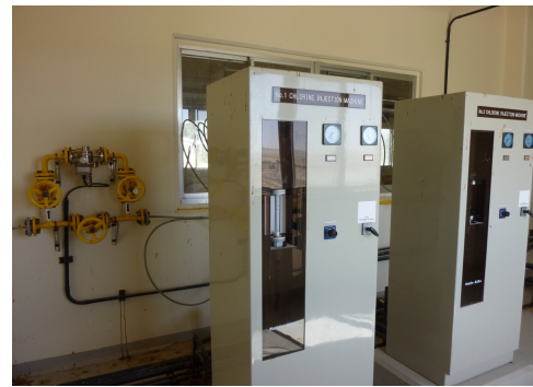
写真 6：調達・据付された塩素消毒機材 （ハウ・ポンプ場）
