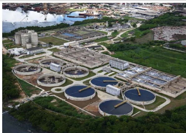
アレグリア下水処理場
