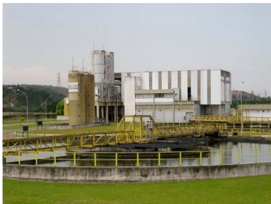
一次処理施設 (サラプイ処理場)
