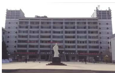
中国側資金で建設された 教学（教育）棟 （甘肅中醫藥學院）
