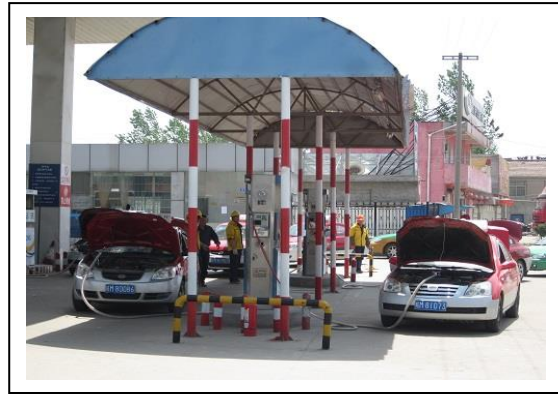
図 20 CNG ステーション（滁州市）
