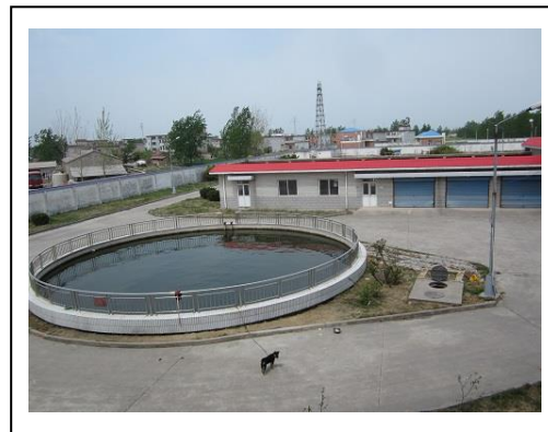
図 22 火災に備えた防水池 (淮南市)
