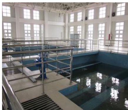
銅川市浄水場のろ過池
