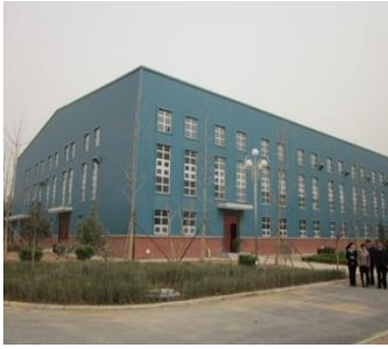
図 6 建屋内設置の浄水場 (銅川市)
