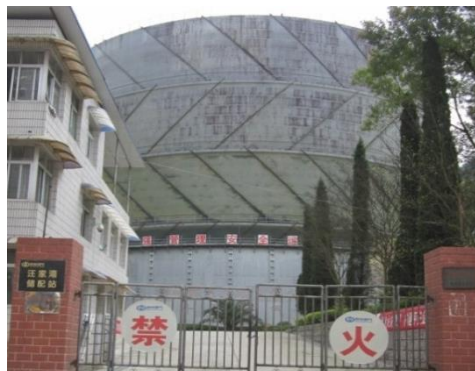
貴陽市都市ガス貯蔵タンク
