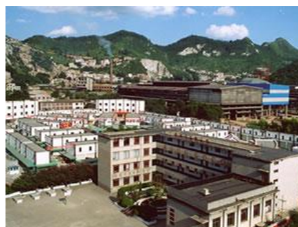
図5 貴陽製鉄工場の周辺 (事業実施後)
