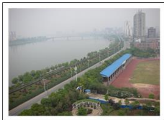
常德市：本事業によって整備された堤防
