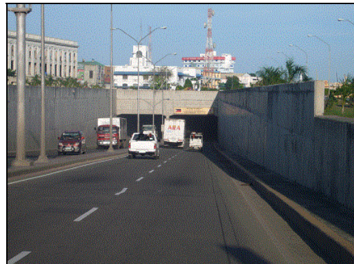
海岸道路 トンネル区間
