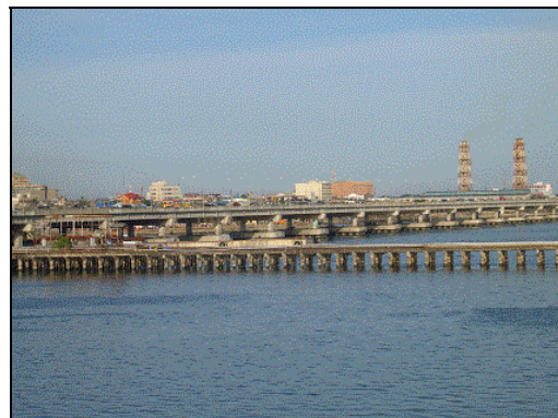
海岸道路 高架区間
