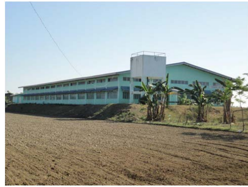
Manambong Sur 避難所
