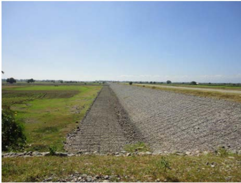
締切堤（側面を撮影）
