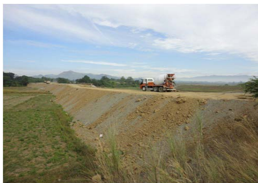
堤防の拡張工事（政府の自己資金による）
