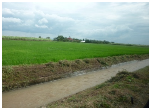
改修された2次水路
