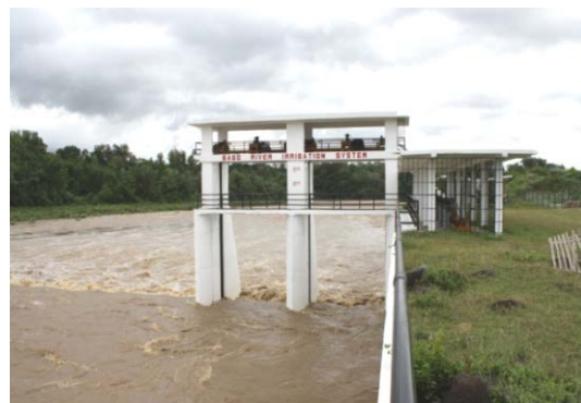
図 14：改修された頭首工とバゴ川
