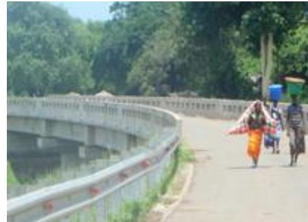
新設された橋（シュエザ橋）
