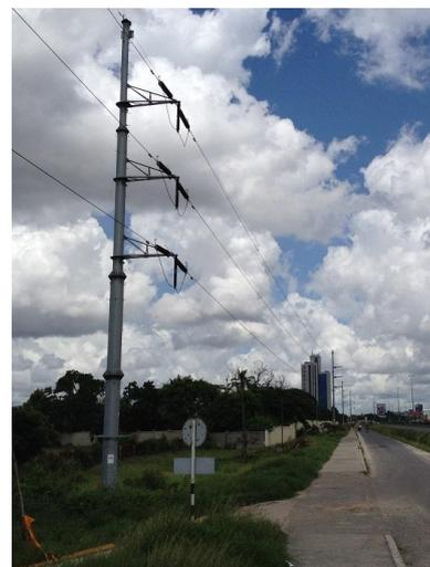
写真2 道路留保地に建設された送電ポール
