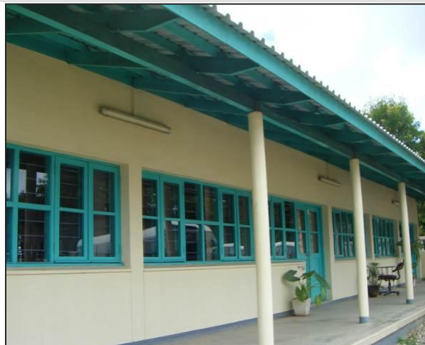
建設された教室（マシンガ人材訓練センター）
